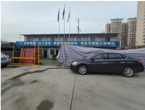
施工生产生活区
