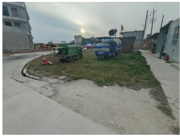
施工生产生活区临时绿化
