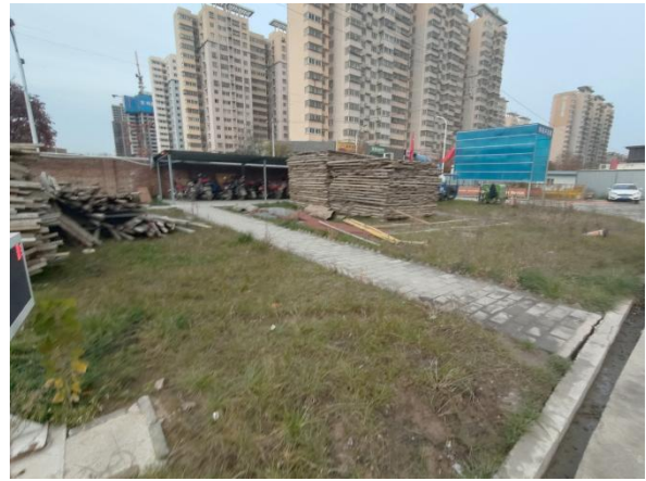
施工生产生活区临时绿化
