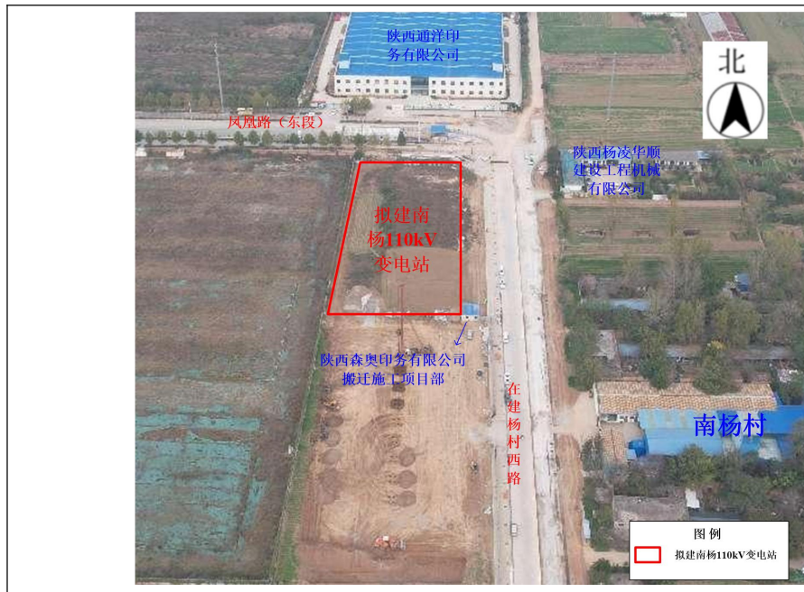
图 2-2 拟建咸阳南杨 110 千伏变电站站址现状照片
