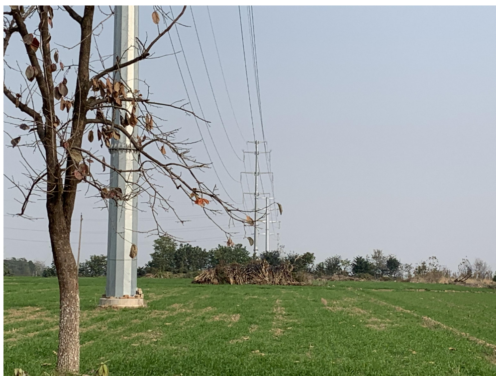
图3-4 输电线路沿线区域土地现状
