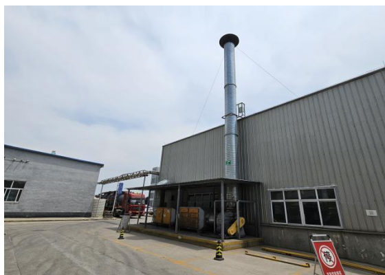
擦洗废气排气筒（DA044）
