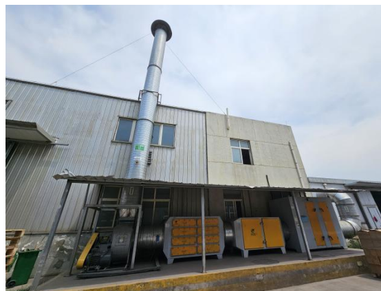
干式过滤箱+两级活性炭箱+排气筒（DA043）
