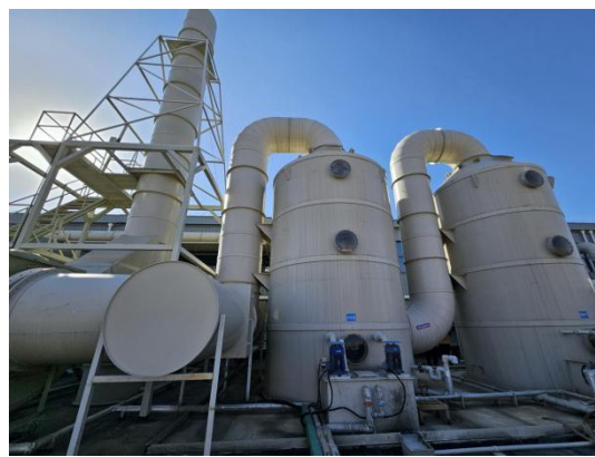
冷凝塔、中和塔、DA001 排气筒
