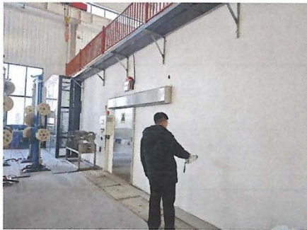
图3 东墙外检测照片
