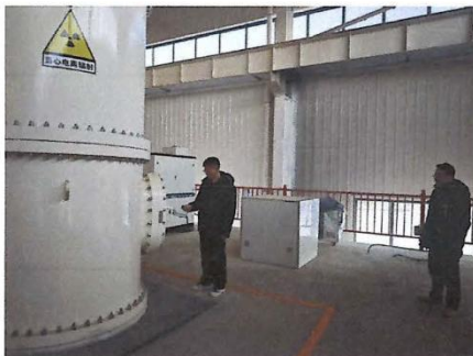
图6 二层平台主机检修口检测照片
